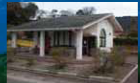
管理棟(WC・更衣室完備)
