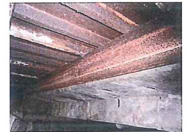
K0121-01_開1号橋 (下流側) (平島平石線)
