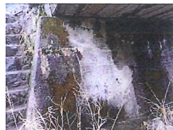
K0031-00_狩集橋 (川原線)
