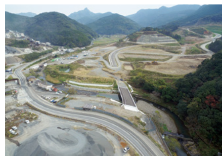
付替県道工事の状況
