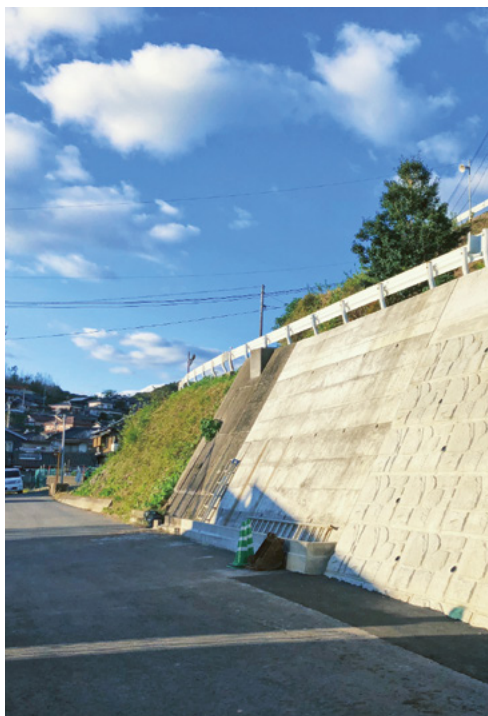
若草地区災害復旧工事現場
