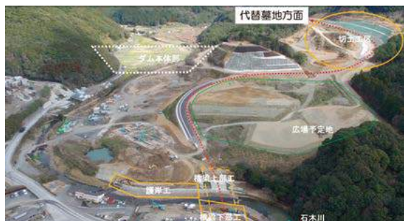
県道付替工事の状況
