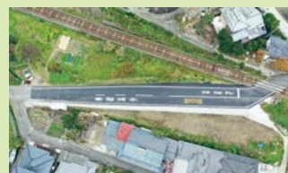
工事完了後の小串郷踏切付近
