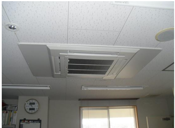
No.12 空調室内機 天井カセット4方向 事務室
