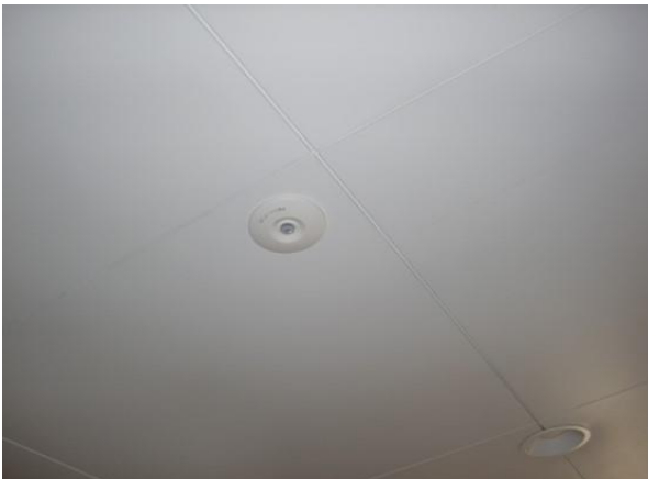
No.23 熱線センサ付自動スイッチ 便所
