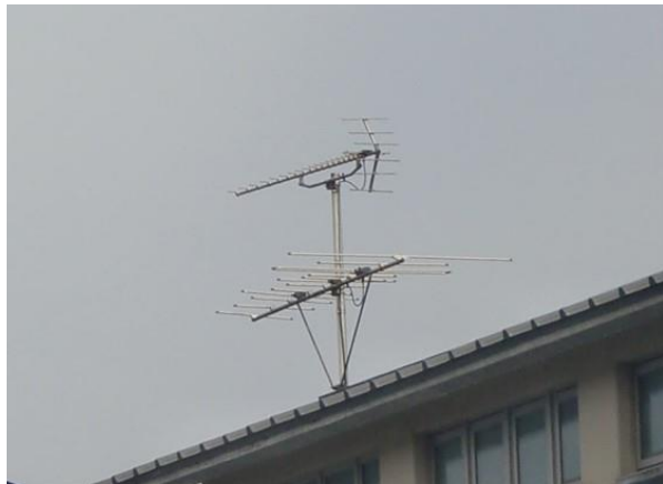
No.84 VHFアンテナ・UHFアンテナ 屋根
