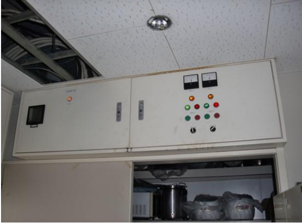
No.9 厨房電灯盤 検収ホール
