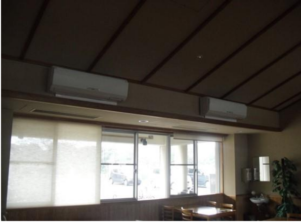
No.9 空調室内機 天吊型 ホール
