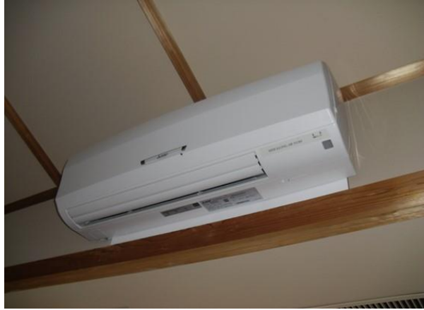
No.10 空調室内機 天吊型 ホール
