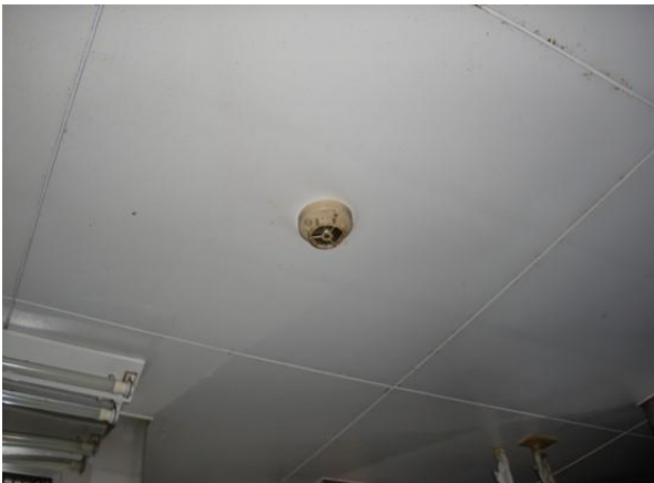
No.11 定温式スポット型感知器1種防水形 厨房
