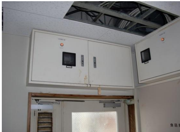
No.6 厨房電灯盤 検収ホール
