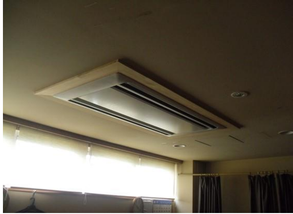
No.28 天井換気扇 事務所(ミニキッチン)
