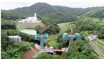
基幹農道川棚西部地区 橋梁建設現場
