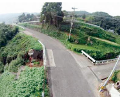
工事予定の堺橋付近
