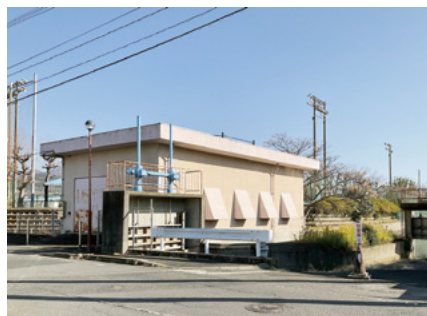
下組ポンプ場
