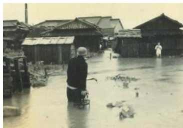
平島地区の浸水
