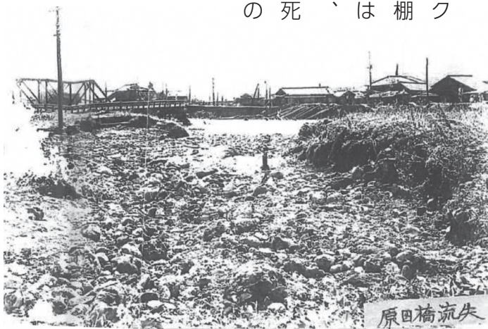
原田橋（現在の川棚大橋）の流失
