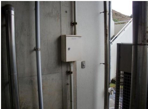
No.167 厨房空調手元開閉器 受水槽置場
