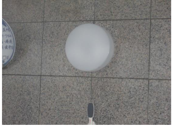
No.82 定温式スポット型感知器1種防水形 サウナ
