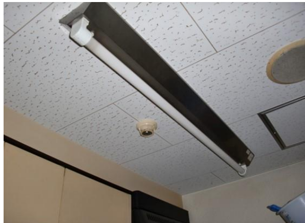
No.60 照明器具・定温式スポット型感知器1種 1階 便所
