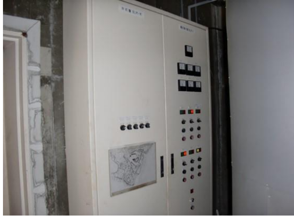
No.190 合併処理制御盤 付属棟
