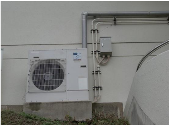
No.185 室外機・2階廊下手元開閉器 外階段
