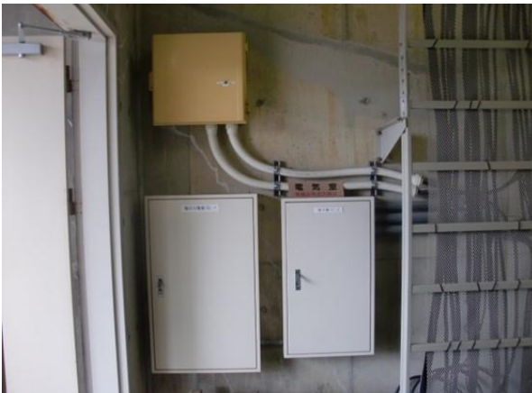
No.173 電灯分電盤 BL-1・端子盤 1T-2 電気室
