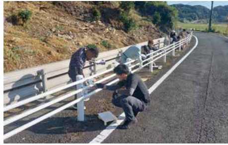
作業を行う建設業協同組合の皆さん
