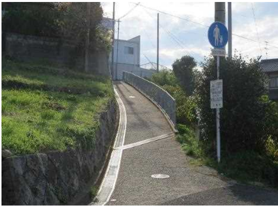
⑦町道宿山道線・県道川棚有田線【対策前】
