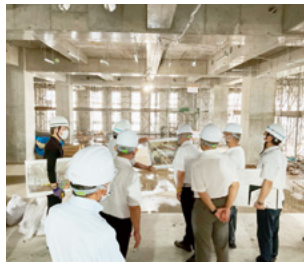
建設中の新庁舎内部
