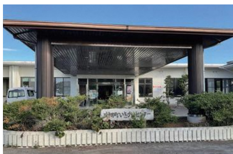
川棚町いきがいセンター
