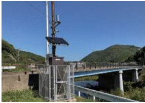
河川監視カメラ
