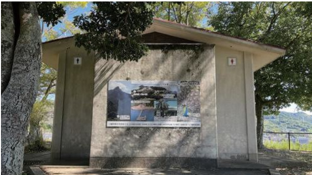
城山公園トイレ
