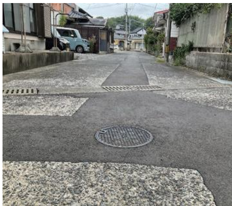
惣津地区下水道工事
